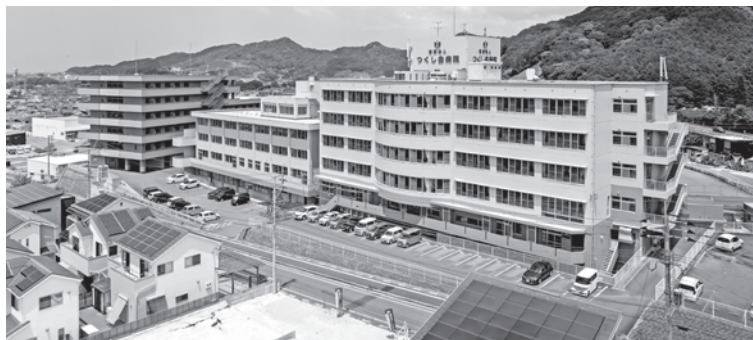
つくし会病院および特別養護老人ホームはなつくし（左奥）
