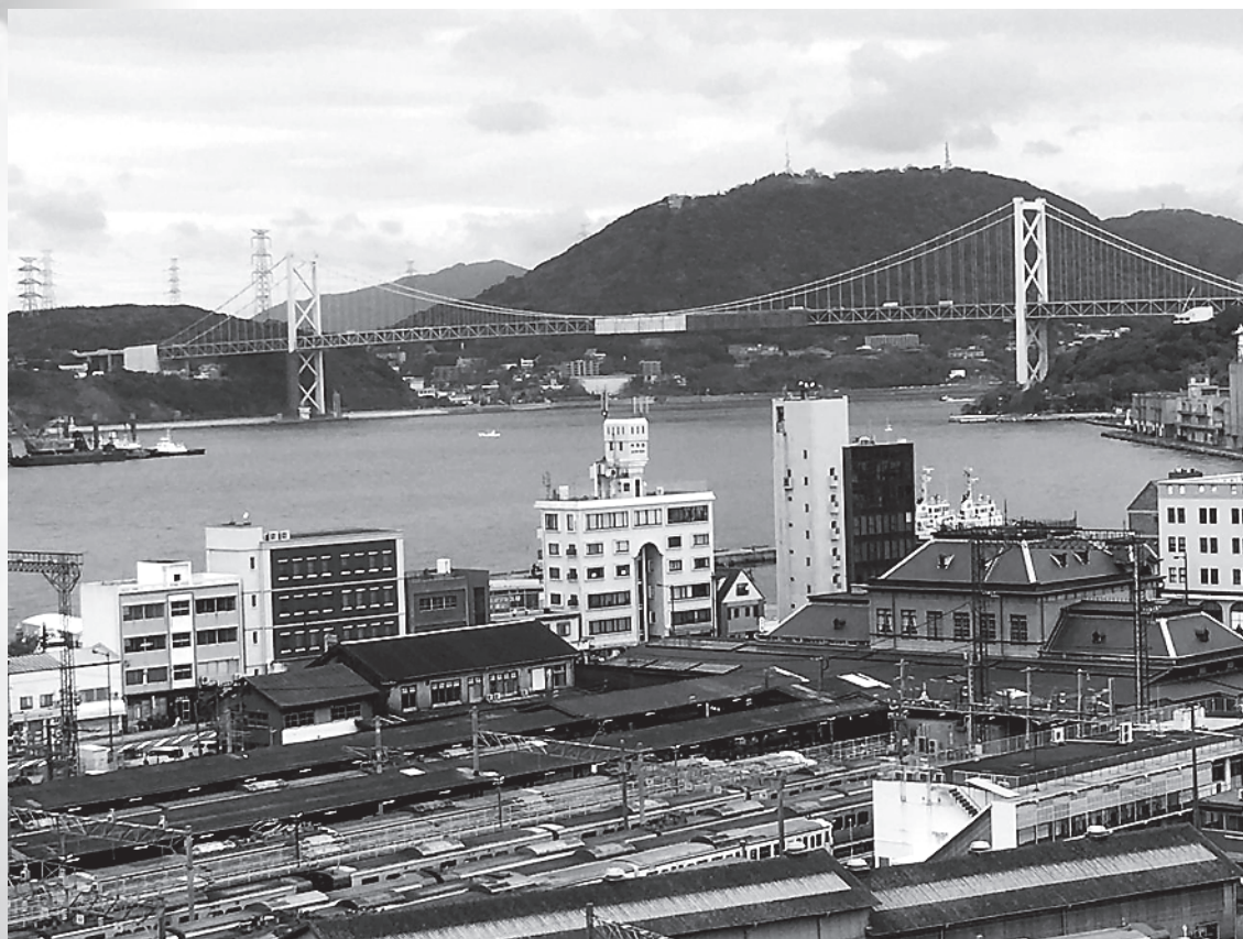
当院病棟より、関門海峡と関門橋を望む。手前は門司港駅。
