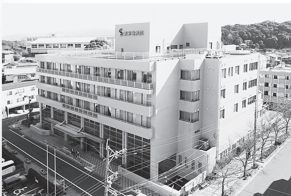
新栄病院全景
