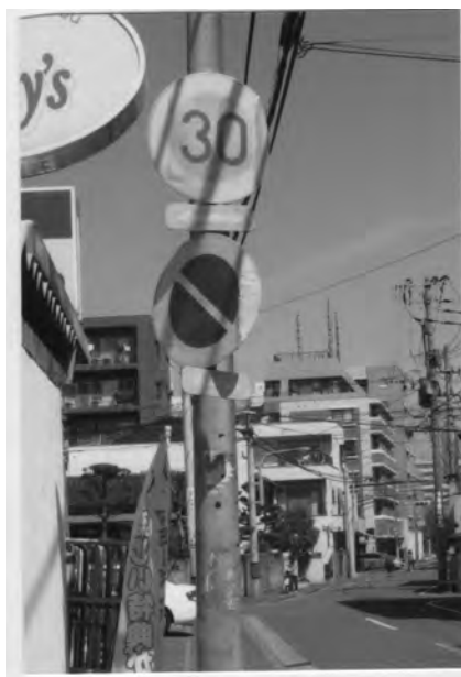
赤い色が褪せた道路標識
